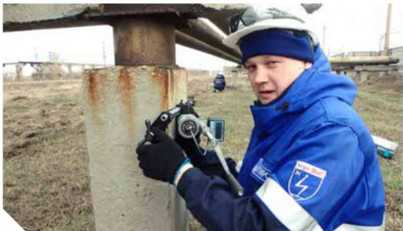
Трубопроводы для откачки некондиционных светлых нефтепродуктов с причалов Нефтерайона «Шесхарис» в резервуарный парк ПК «Шесхарис». Заказчик: ПАО «НМТП».
