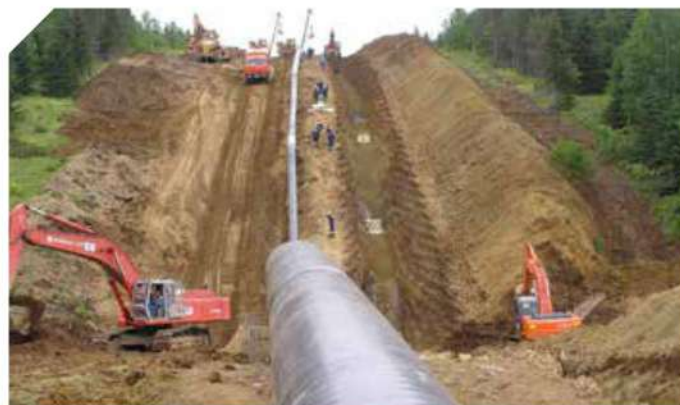
Строительство нефтепровода Среднеботуобинское НГКМ — трубопроводная система ВСТО с углом подключения в районе г. Ленск. Заказчик: ООО «Таас-Юрях Нефтегаздобыча».
