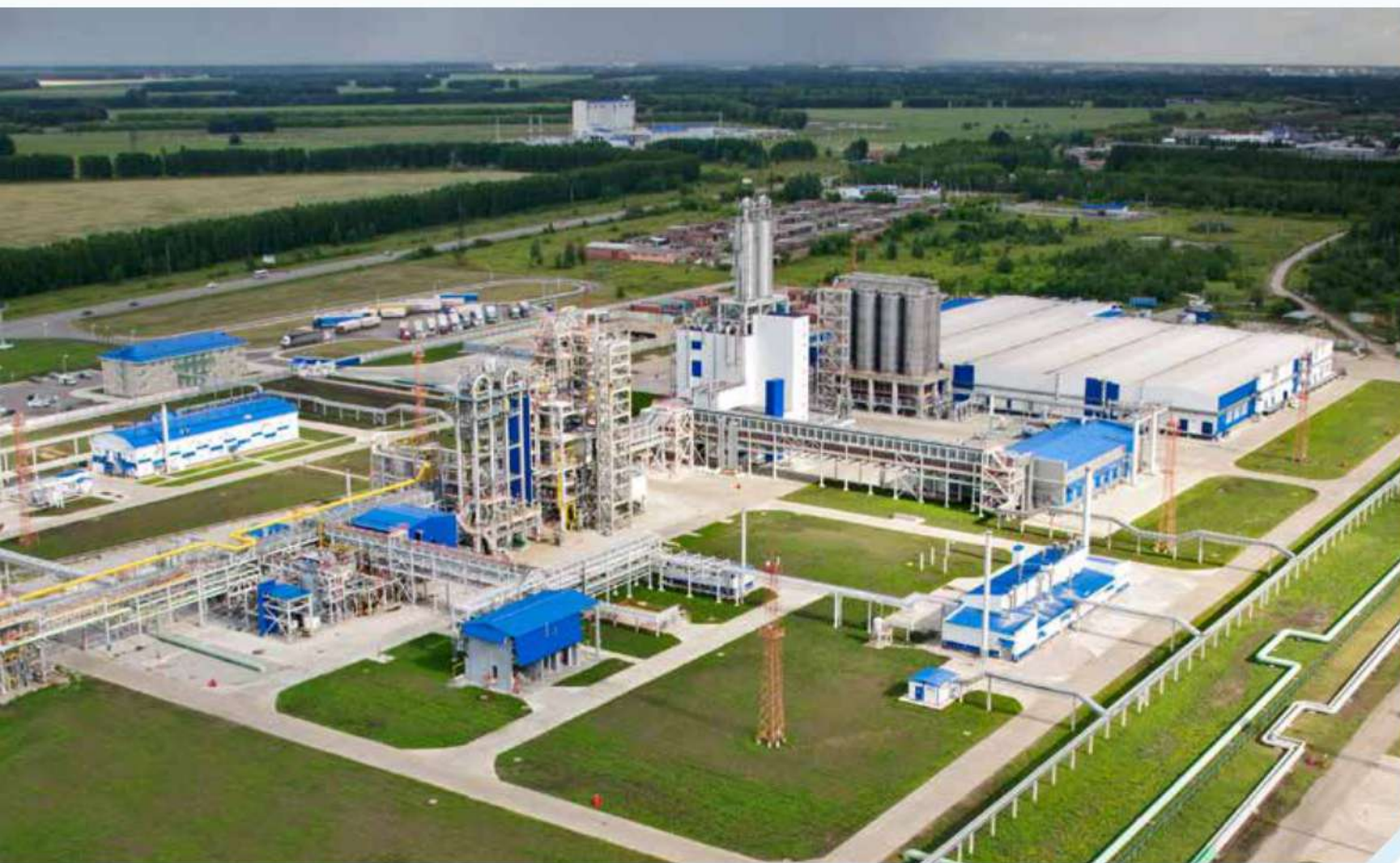
Комплекс установки производства полипропилена («Полиом»).
