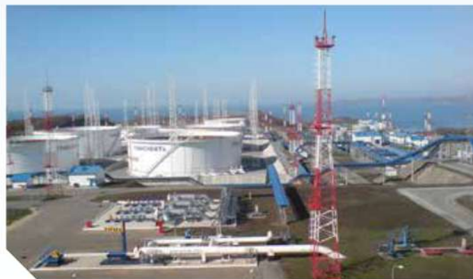
Балтийская трубопроводная система-II (БТС-II). Заказчик: ПАО «Транснефть».
