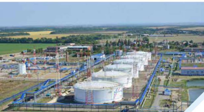
Проект «Юг». 1 этап. Реконструкция ж/д эстакады ПНБ «Тихорецкая». Заказчик: АО «Черномортранснефть».
