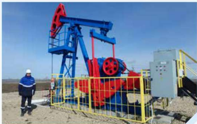
Реконструкция ДНС-2 Актанышского нефтяного месторождения. Заказчик: ООО «МНКТ».
