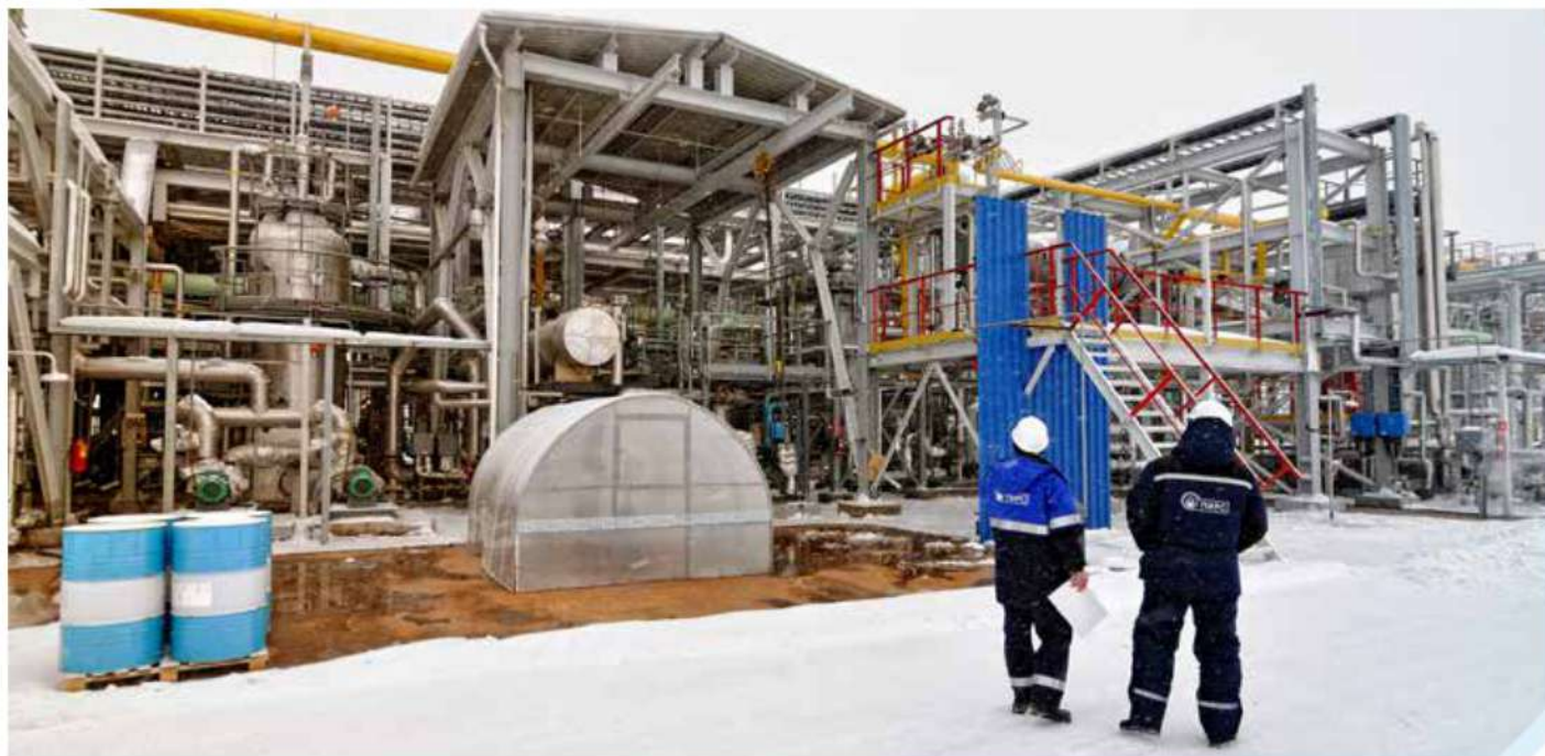
Комплекс установки производства полипропилена («Полиом»). Заказчик: ООО «Полиом».
