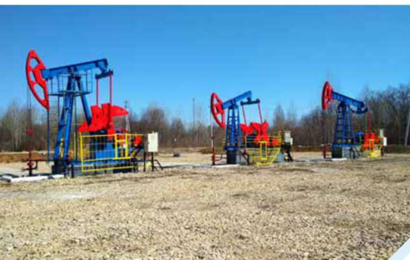
Реконструкция ДНС-2 Актанышского нефтяного месторождения. Заказчик: ООО «Малая Нефтяная Компания Татарстана» (ООО «МНКТ»).
