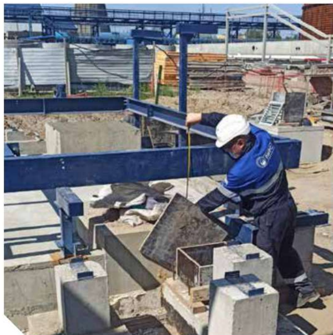
Реконструкция установки замедленного коксования 21-10/ЗМ. Заказчик: «АО Газпромнефть – ОНПЗ».
