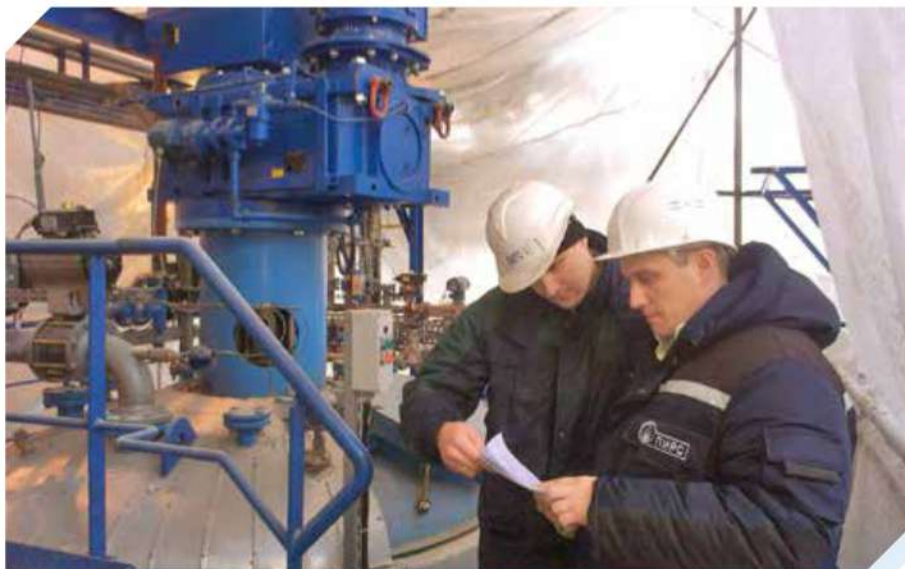
Реконструкция установки литиевых смазок. Заказчик: ООО «Газпромнефть-СМ».
